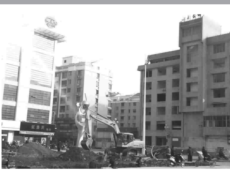
连日来,文峰街道迅速贯彻落实市、区领导要求,抽调精干力量,严格落实责任,发扬“5+2”、“白+黑”精神,强势推进迎宾路、解放路拆迁工作,取得了明显成效。图为该街道拆迁让地后BRT工程顺利施工的场景。
